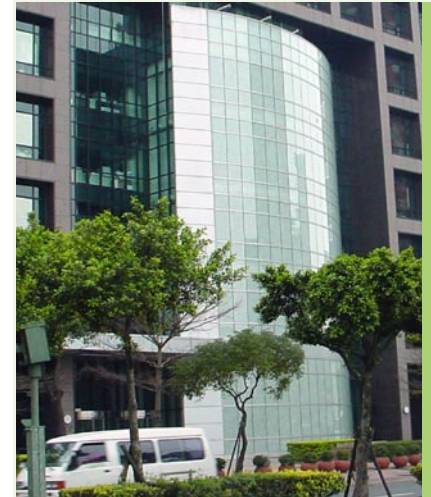
Bürogebäude in Taiwan: Tageslichtsysteme tragen zur besonderen Architektur des Verwaltungsbaus bei.
