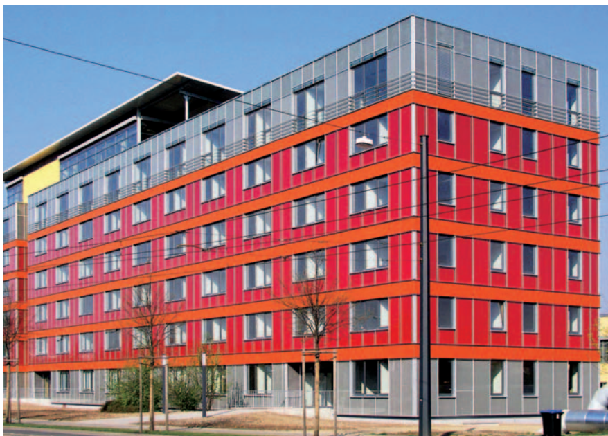
Solare Wärmedämmung: Die Glaselemente mit Dämm-Material erwärmen sich durch die Sonne und hüllen das Gebäude in einen Wärmemantel.
