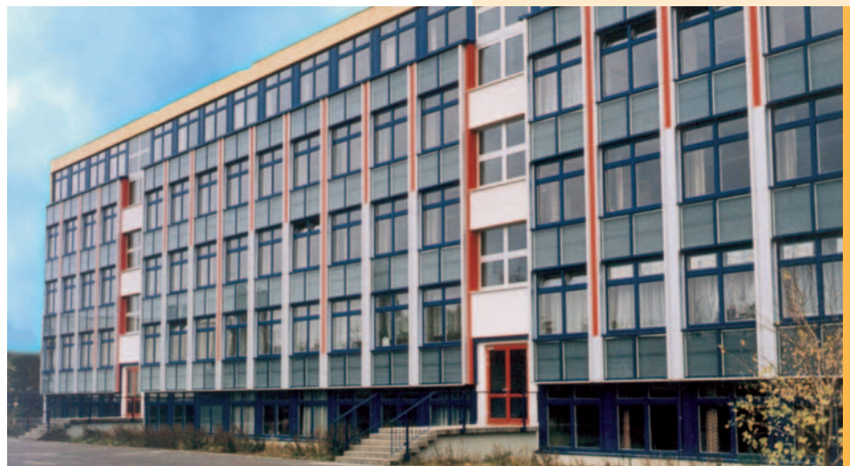
Transparente Wärmedämmung als Vorhangfassade.
