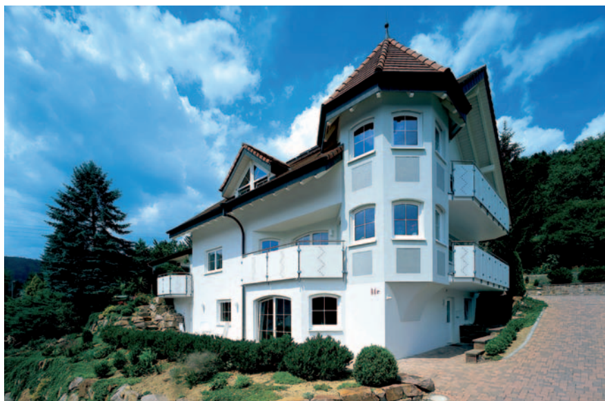
Technisch ausgereift, architektonisch reizvoll: Die Solare Umweltwand (dunkle Flächen) an einem Einfamilienhaus in Süddeutschland.
